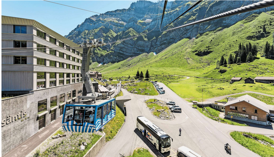
Die Säntis-Schwebebahn wird in diesem Sommer erneuert, die Bahnstrecke ist ab 1. Mai geschlossen.
